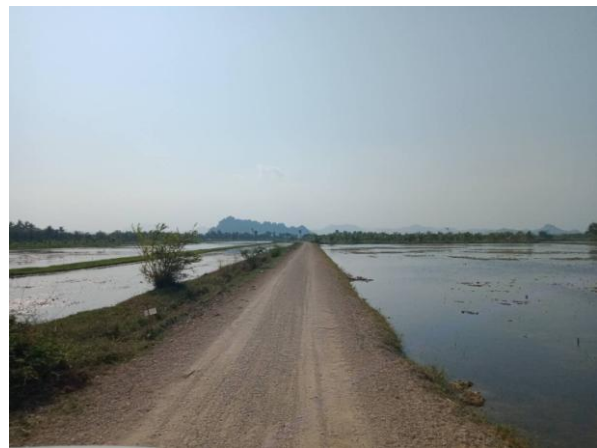
ก่อสร้างถนนหินคลุกบดอัดแน่น บริเวณซอยบ้านผู้ใหญ่ สำอางค์ ทางเข้าคลองบาง (บ้านน้อย) หมู่ ๖ ตำบลเขา
