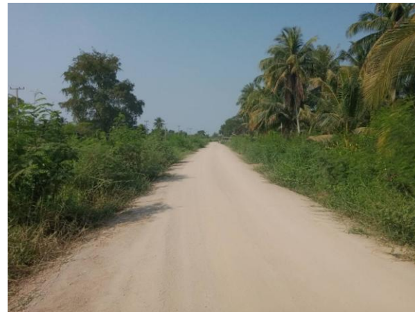
ก่อสร้างถนนหินคลุกบดอัดแน่น จากสะพานบ้านครูอุบล ถึงบ้านนายสมบัติ บัวบาน (บ้านน้อยพัฒนา) หมู่ ๖ ตำบลเขาย้อย
