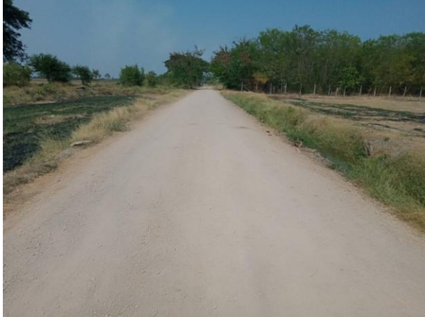
ก่อสร้างถนนหินคลุกบดอัดแน่น ซอยทางลงนาหนองบัว หมู่ ๓ ตำบลบางเค็ม
