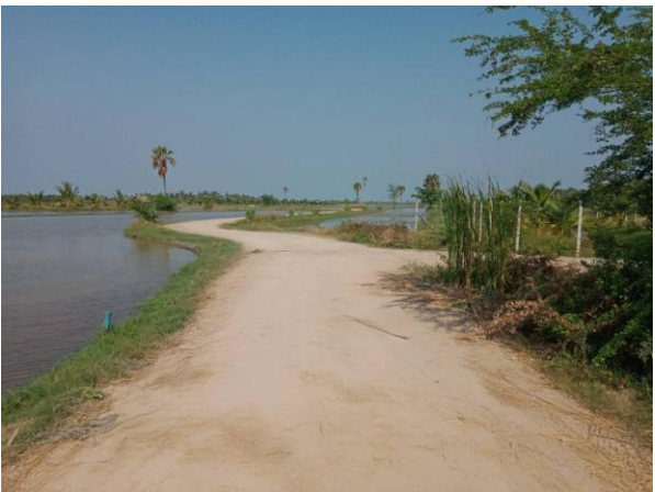
ก่อสร้างถนนหินคลุกบดอัดแน่น บริเวณทางเข้าคลองบาง (บ้านน้อย) หมู่ ๖ ตำบลเขาย้อย
