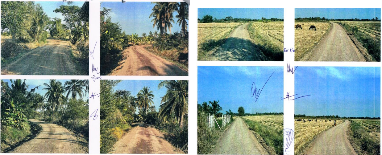
ก่อสร้างท่อเหลี่ยมระบายน้ำ คสล. พร้อมฝาปิด เปิด ทุก ระยะ 10.00 เมตร ต่อจากของเดิมถึงบ้านนางเฉลียว วังเวงจิต และเชื่อมต่อถึงบ้านนายสิน นาคทอง หมู่ 2
