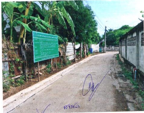
โครงการก่อสร้างท่อเหลี่ยมระบายน้ำ คสล. จากบ้านนาง พรวิไล พุ่มสวัสดิ์ ถึงสามแยกบ้านนายจรูญ พรมคุ้ม หมู่ ๕ ตำบลบางเค็ม
