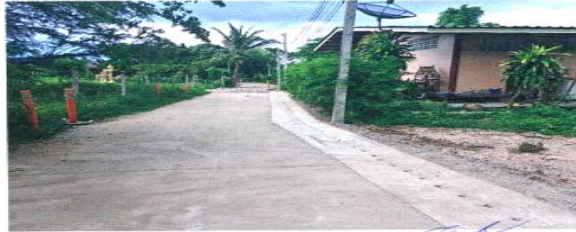
โครงการก่อสร้างท่อเหลี่ยมระบายน้ำ คสล. จากบ้านนาย ประมวลแย้มพงษ์ ถึง ถนนเลียบคลองชลประทาน(บ้าน พร้อมใจ) หมู่ ๒ ตำบลสระพัง
