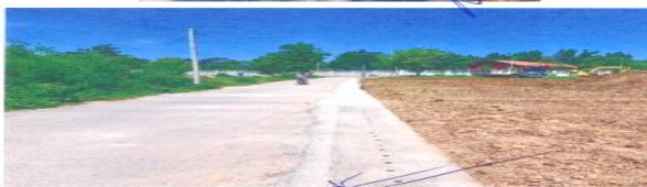
โครงการก่อสร้างท่อเหลี่ยมระบายน้ำ คสล. จากบ้านนาง บุญล้อม สว่างชาติ ถึงบ้านนายกฤษดา ไกรทองสุข หมู่ ๔ ตำบลบางเค็ม
