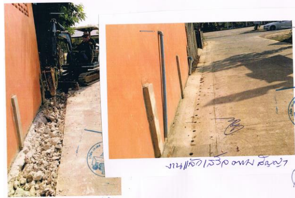
โครงการก่อสร้างท่อเหลี่ยมระบายน้ำ คสล. จากบ้านนาย ไว ถึง เดิมทอง (บ้านสระพัง) หมู่ ๑ ตำบลสระพัง
