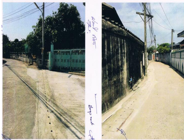
โครงการก่อสร้างท่อเหลี่ยมระบายน้ำ คสล. จากบ้านนาง อารมณ์ อำไพรัตน์ ถึงบ้านนางหวาน (บ้านสระพัง) หมู่ ๑ ตำบลสระพัง
