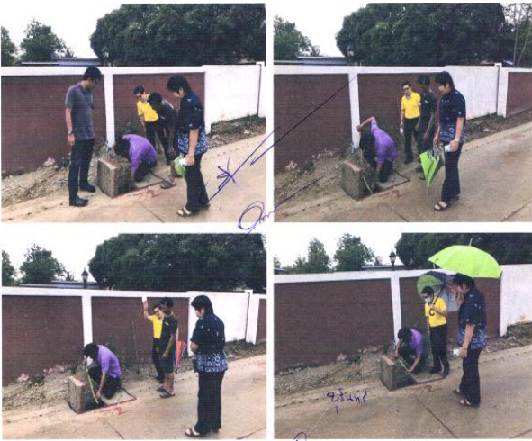
โครงการก่อสร้างท่อเหลี่ยมระบายน้ำ คสล. ซอย ๒ จาก บ้านนายสนิท คุ้มน้อย ถึง บ้านนายสันต์ เรืองน้อย หมู่ ๒ ตำบลเขาย้อย
