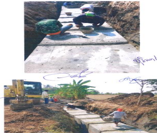
โครงการก่อสร้างบล็อกคอนเวิร์ต บริเวณคลองทิ้งน้ำปลาย นานายสวิง ยืนเยี่ยม (ดอนทรายร่วมใจฝั่งล่าง) หมู่ ๑ ตำบลทับคา
