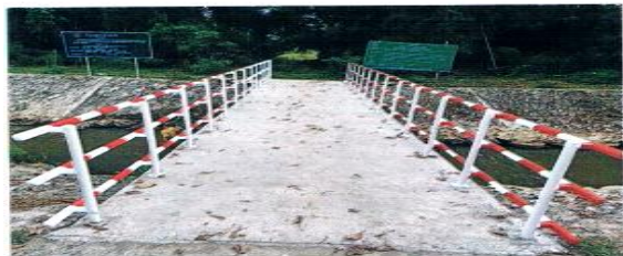
ก่อสร้างท่อเหลี่ยมระบายน้ำ คสล. พร้อมฝาปิด เปิด ทุก ระยะ 10.00 เมตร ต่อจากของเดิมถึงบ้านนางเฉลียว ว่างเวงจิต และเชื่อมต่อถึงบ้านนายสิน นาคทอง หมู่ 2
