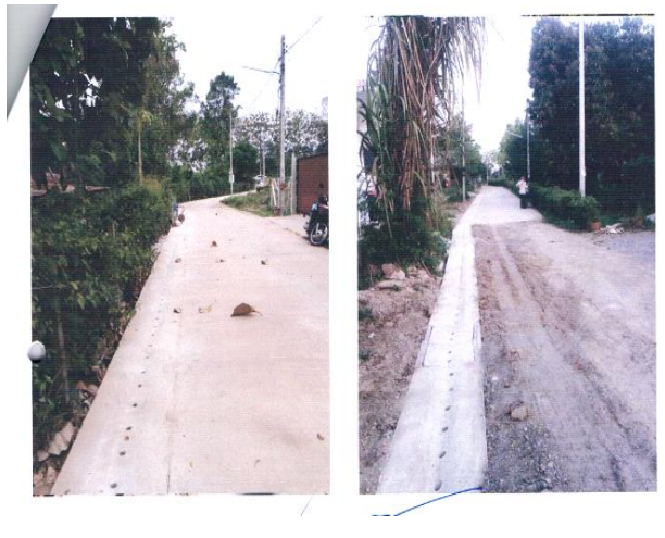
โครงการก่อสร้างท่อเหลี่ยมระบายน้ำ คสล. จากถนน เพชรเกษม ถึง บ้านนางเย็นจิต สินสุรี หมู่ ๒ ตำบลสระพัง
