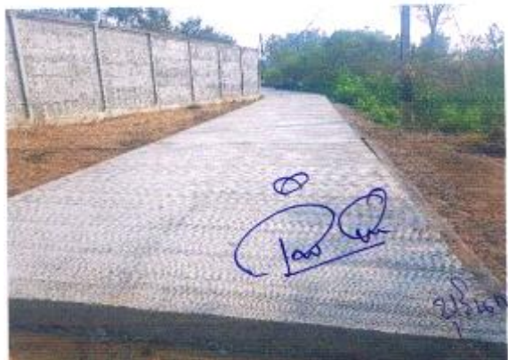
โครงการก่อสร้างถนน คสล. จากบ้านนายพิศาล พวกสนิท ถึงคลองประตู่ (บ้านบางเค็มพัฒนา) หมู่ ๔ ตำบลบางเค็ม
