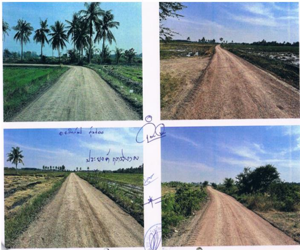
โครงการก่อสร้างถนนหินคลุกบดอัดแน่นบริเวณทางเข้านา ดอนไผ่แหลม หมู่ ๔ ตำบลสระพัง
