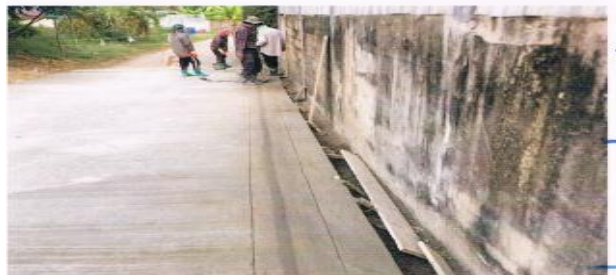
โครงการก่อสร้างยกระดับถนน คสล. บริเวณซอยบ้านใต้ วัด ข้างรั้วร้านครุน้อย (ดอนทรายร่วมใจฝั่งล่าง) หมู่ ๑ ตำบลทับค้าง
